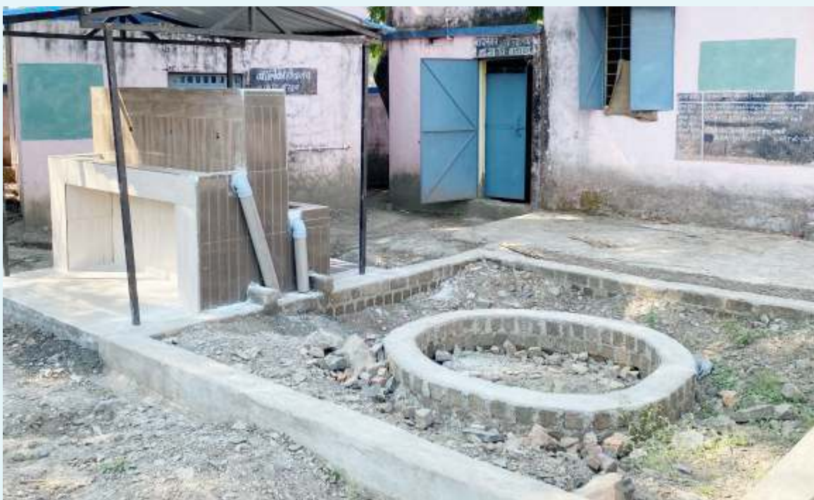
विभाग द्वारा संचालित ग्राम नल जल योजनाओं के पेयजल स्रोतों के संवर्धन हेतु जल उपलब्ध क्षेत्र में रिचार्ज पिट का निर्माण- ग्राम बासला, विकासखण्ड कालापीपल, जिला शाजापुर
