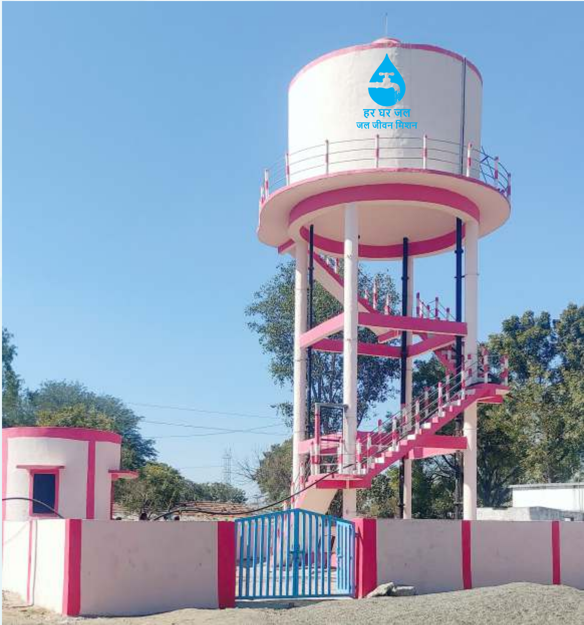
ग्राम सांगाखेड़ा, जिला रतलाम में जल जीवन मिशन के अन्तर्गत जल प्रदाय व्यवस्था हेतु उच्च स्तरीय पेयजल टंकी का निर्माण, क्षमता 1 लाख लीटर
