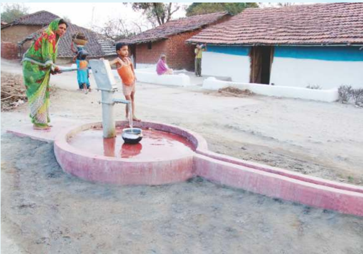
ग्रामीण क्षेत्रों में हैंडपम्प/प्लेटफार्म निर्माण एवं स्थापना – ग्राम भैंसादण्ड, विकासखण्ड छिन्दवाड़ा, जिला छिन्दवाड़ा
