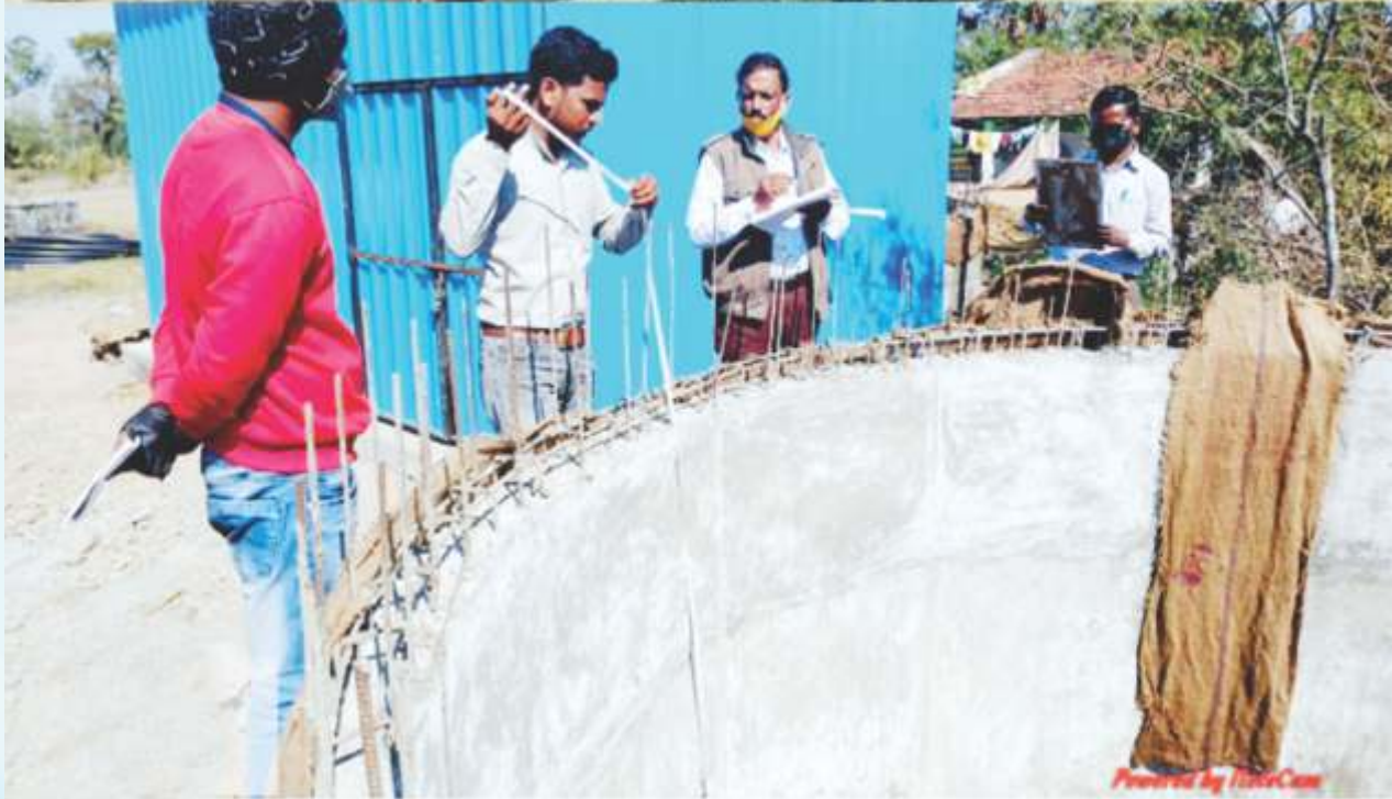
जल जीवन मिशन के अन्तर्गत सूचीबद्ध तृतीय पक्ष द्वारा निर्माण कार्यो का निरीक्षण—जिला खण्डवा
