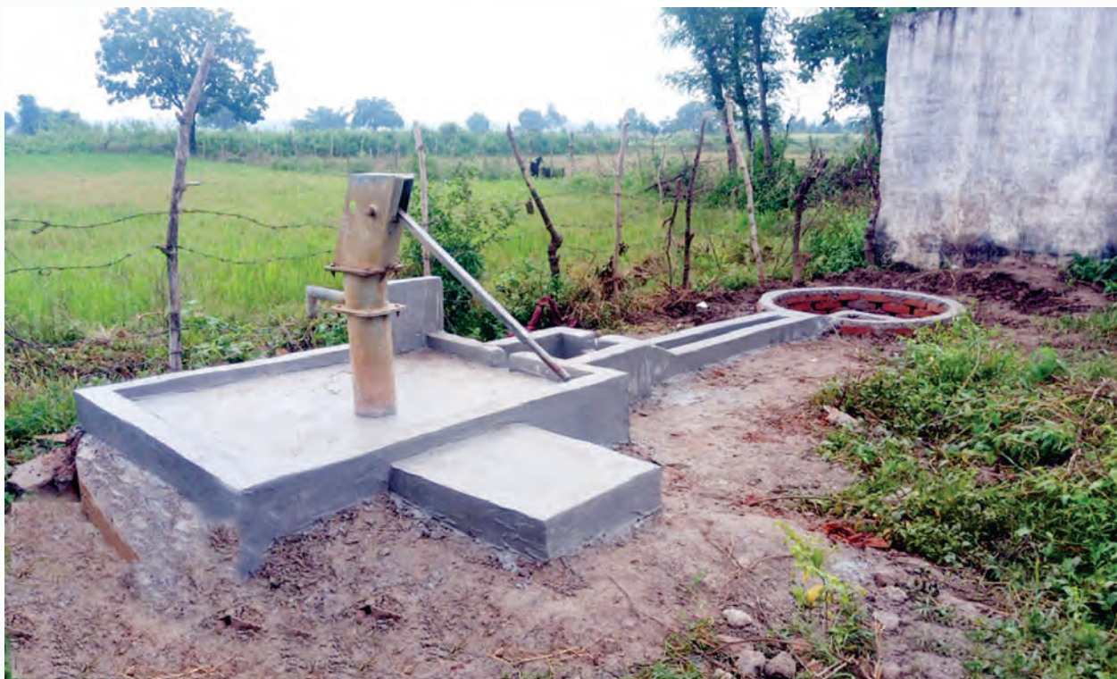
ग्रामीण क्षेत्रों में हैंडपंप प्लेटफार्म का निर्माण, जिला सतना
