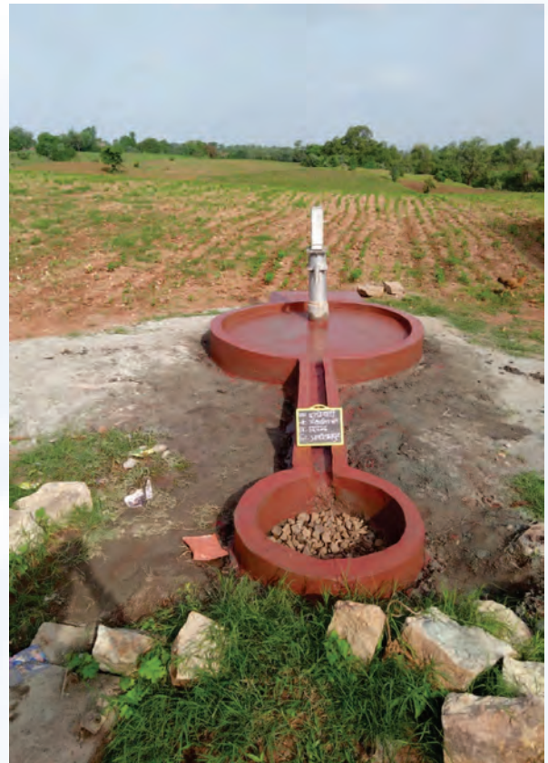
ग्रामीण क्षेत्रों में मैकेनिकल खण्ड उज्जैन द्वारा निर्मित हैंडपंप-प्लेटफार्म
