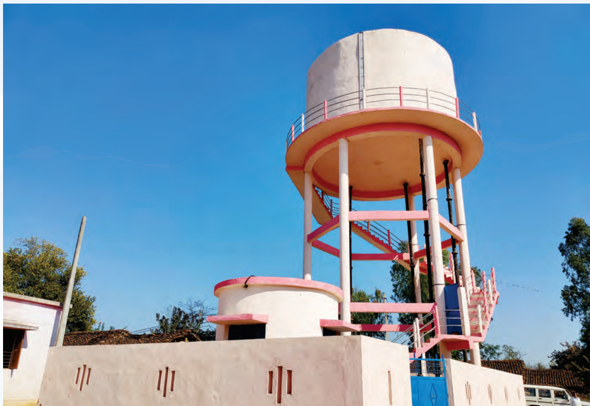
मुख्यमंत्री नलजल योजना ग्राम झरकुआ, विकास खण्ड पन्ना में निर्मित उच्च स्तरीय पेयजल टंकी क्षमता 175 कि.ली., 12 मीटर स्टेजिंग
