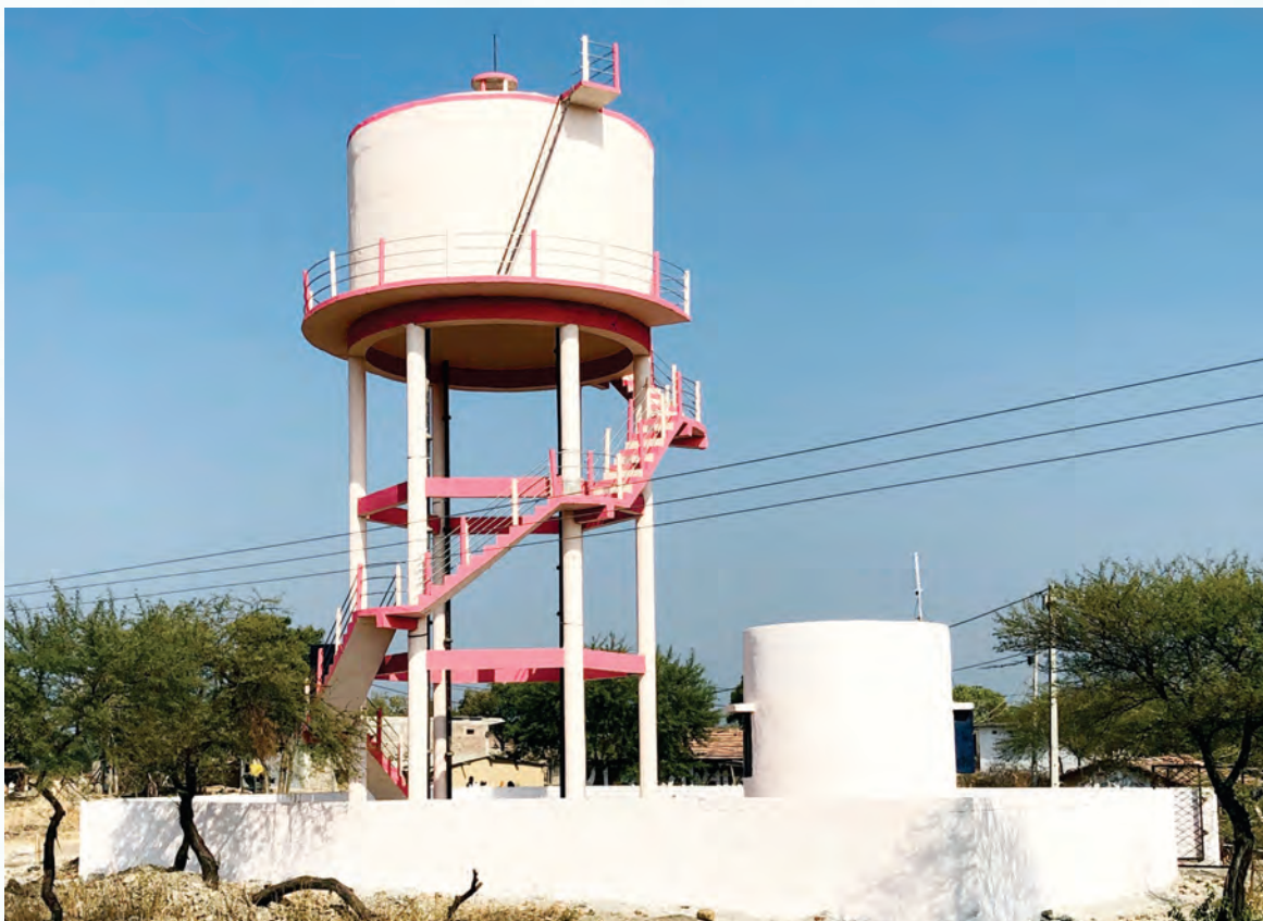
ग्रामीण पेयजल कार्यक्रम के अन्तर्गत आर.सी.सी. उच्चस्तरीय टंकी का निर्माण— ग्राम—ईसनखेड़ी, विकासखण्ड—महिदपुर, जिला उज्जैन
