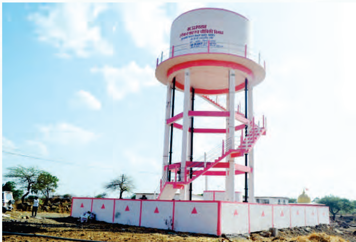
ग्रामीण पेयजल कार्यक्रम के अन्तर्गत आर.सी.सी. उच्चस्तरीय टंकी का निर्माण- ग्राम-लुन्हेरा, विकासखण्ड-नालछा, जिला धार
