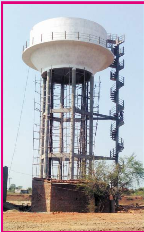
खुरई आवर्धन पेयजल परियोजना के अन्तर्गत उच्चस्तरीय पेयजल टंकी का निर्माण
