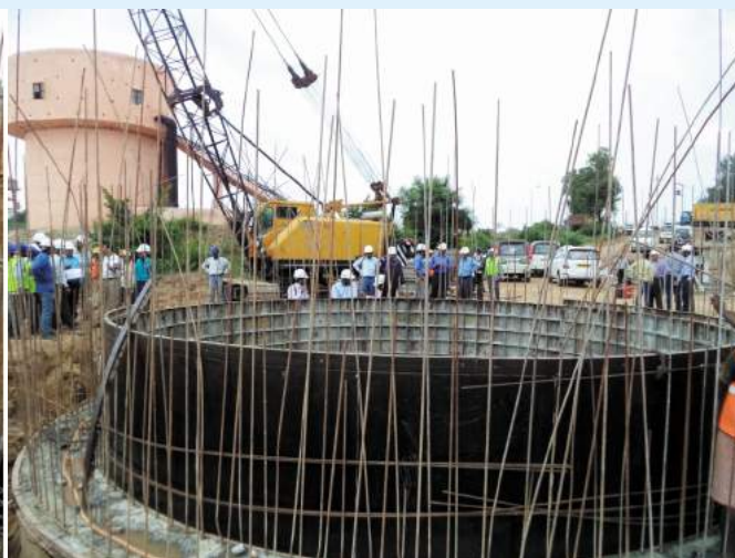
मरदानपुर स.ज.प्र.यो. इन्टेक वेल निर्माण
