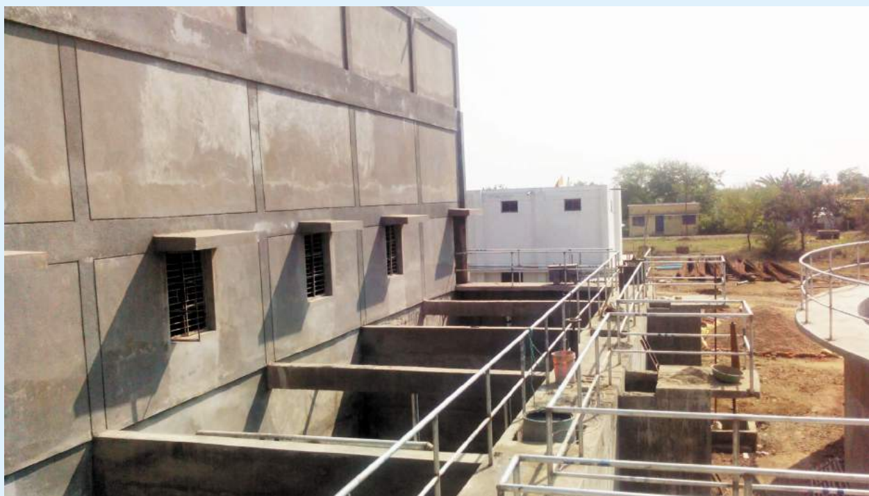
खुरई, जिला सागर आवर्धन पेयजल परियोजना के अन्तर्गत जल शुद्धिकरण संयंत्र का निर्माण, क्षमता 12.80 एम.एल.डी.
