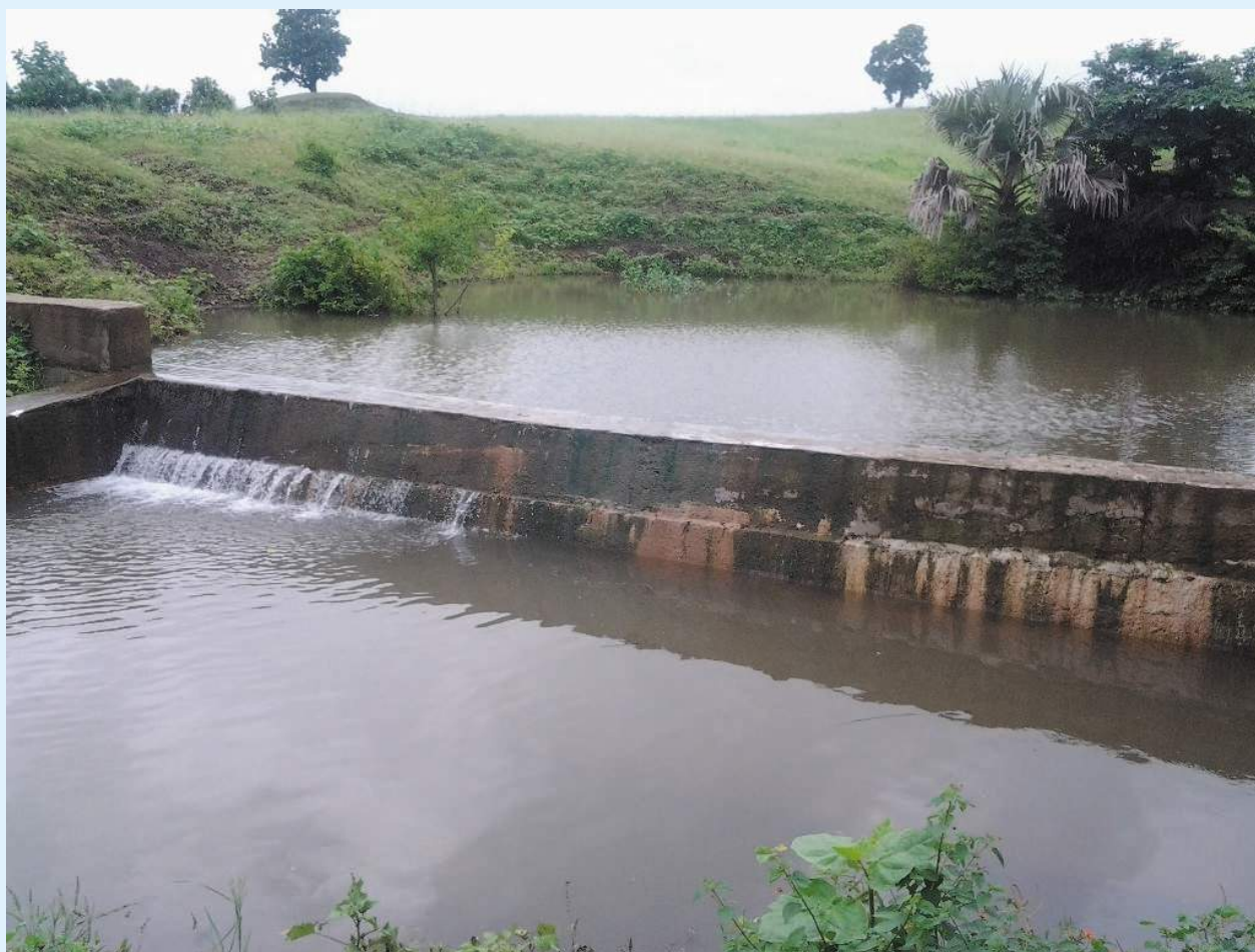
भूजल संवर्धन कार्यक्रम के अन्तर्गत, ग्राम अम्भाजा, विकासखंड सोडवा, जिला अलीराजपुर में चैक डैम का निर्माण
