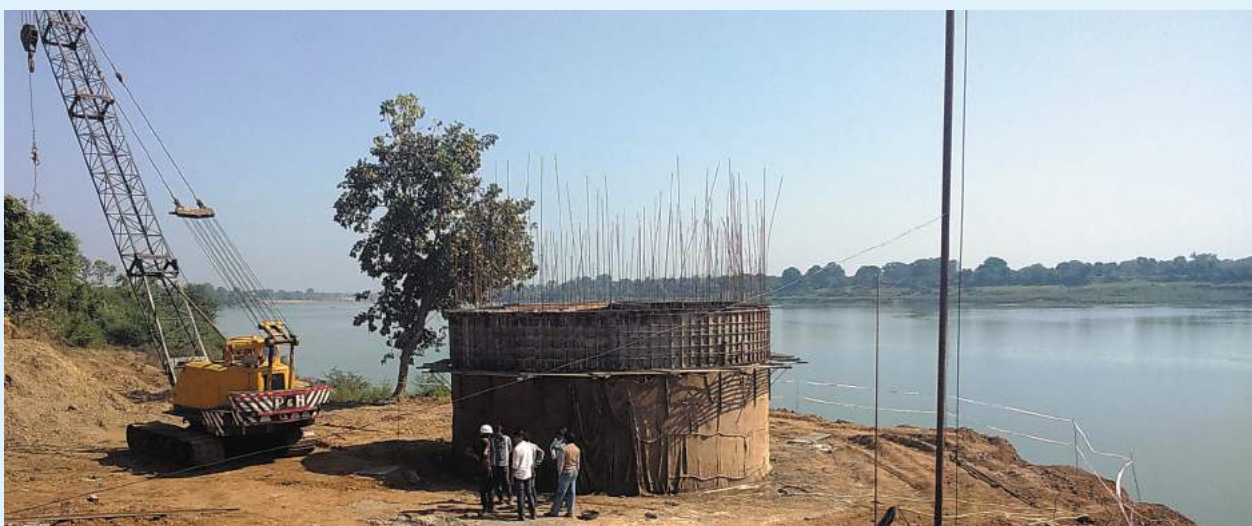
मरदानपुर समूह पेयजल योजना के इन्टेक वेल का निर्माण
