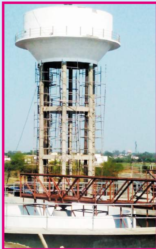
खुरई आवर्धन पेयजल परियोजना के अन्तर्गत उच्चस्तरीय पेयजल टंकी का निर्माण
