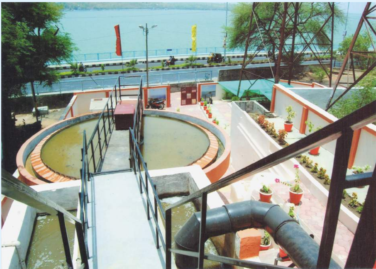
तरल अपशिष्ट उपचार संयंत्र की क्लैरीफायर एवं फ्लाक्युलेटर यूनिट, हमीदिया चिकित्सालय भोपाल
