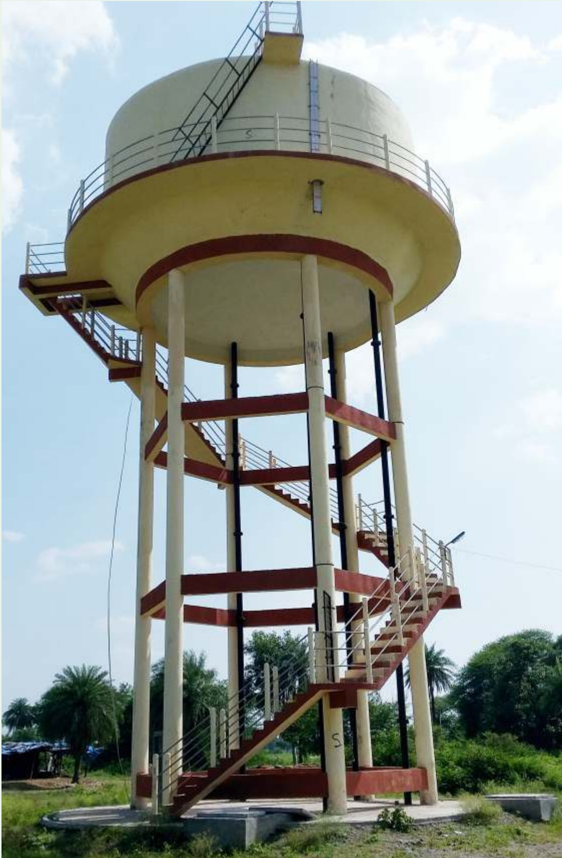
ग्राम खरसोद कला, विकासखण्ड बड़नगर, जिला उज्जैन में निर्मित उच्च स्तरीय पेयजल टंकी, स्टेजिंग 15 मीटर, क्षमता 270 कि.ली.
