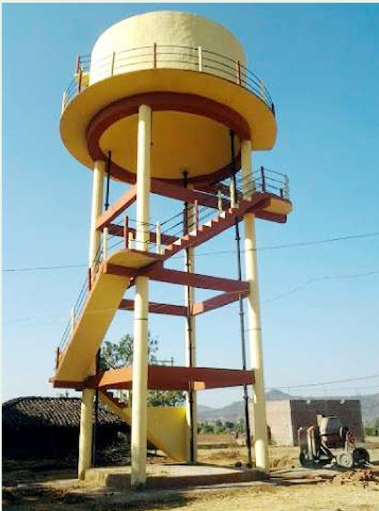
जनभागीदारी अंतर्गत ग्रामीण नल जल प्रदाय योजना के अंतर्गत आर.सी.सी.उच्चस्तरीय टंकी का निर्माण कार्य, क्षमता 80 कि.ली., ऊँचाई 12 मी. ग्राम सलवाह, पंचायत सलवाह, विकासखण्ड घुघरी, जिला मण्डला
