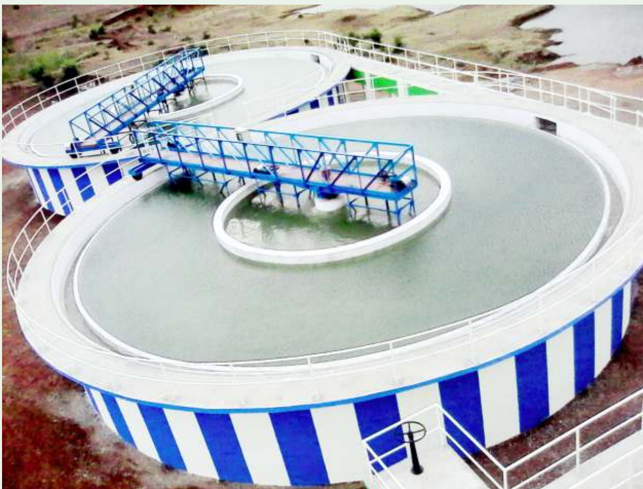
खुरई नगर आर्बधन जल प्रदाय योजना (डिपॉजिट वर्क), में निर्मित जल शोधन सयंत्र, क्षमता 12.8 एम.एल.डी, फ्लाकुलेटर
