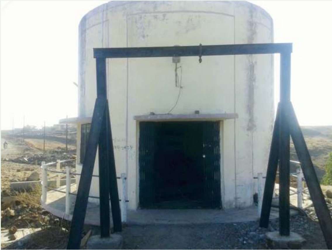
ग्रामीण नलजल योजनाओं के क्रियान्वयन हेतु इंटेक वेल का निर्माण ग्राम चारणकोटड़ा, विकासखण्ड पेटलावद, जिला झाबुआ
