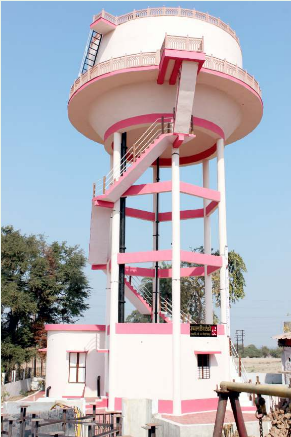
गढ़कालिका मेला क्षेत्र में पेयजल व्यवस्था हेतु आर.सी.सी. उच्च स्तरीय टंकी निर्माण एवं अन्य कार्य – उज्जैन
