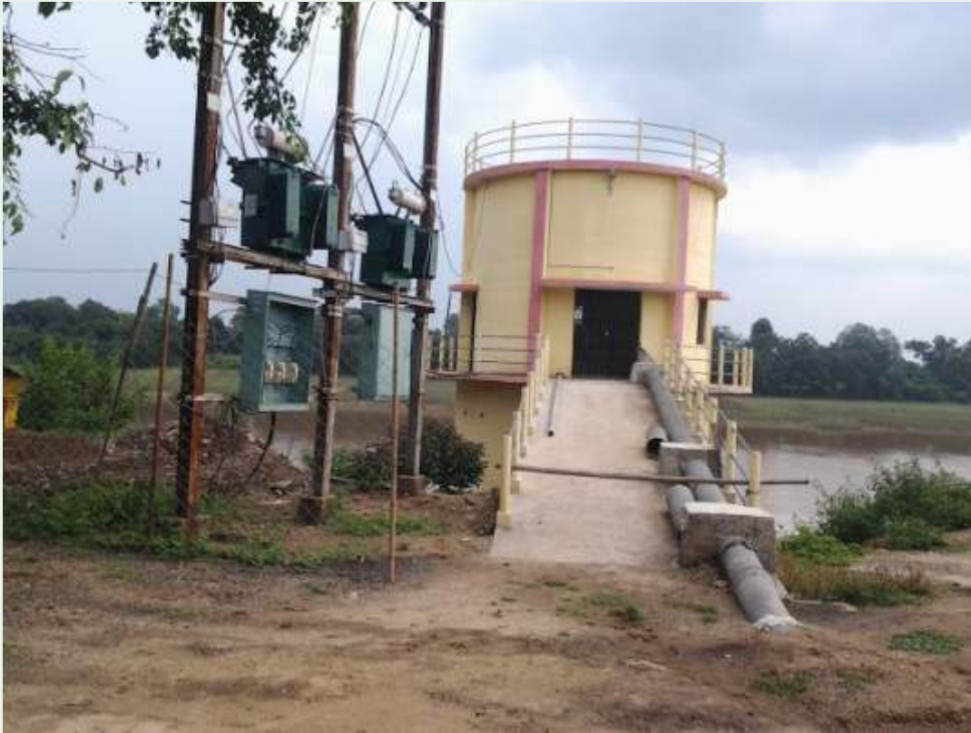
गुणवत्ता प्रभावित बसाहटों की समूह नल जल प्रदाय योजना, नर्मदा नदी पर आर.सी.सी. इंटेकवेल सह पम्प हाउस का निर्माण कार्य, व्यास 6.0 मी. ऊँचाई 18 मी. ग्राम एवं पंचायत बड़ी खैरी, विकासखण्ड-मण्डला, जिला मण्डला
