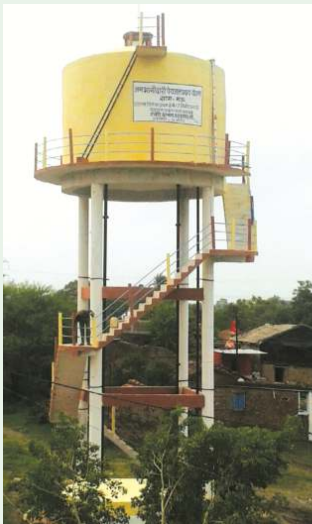
ग्रामीण नलजल योजना के क्रियान्वयन के अन्तर्गत पेयजल प्रदाय उच्च स्तरीय टंकी, क्षमता 80000 लीटर का निर्माण, ग्राम मऊ विकासखण्ड रतलाम
