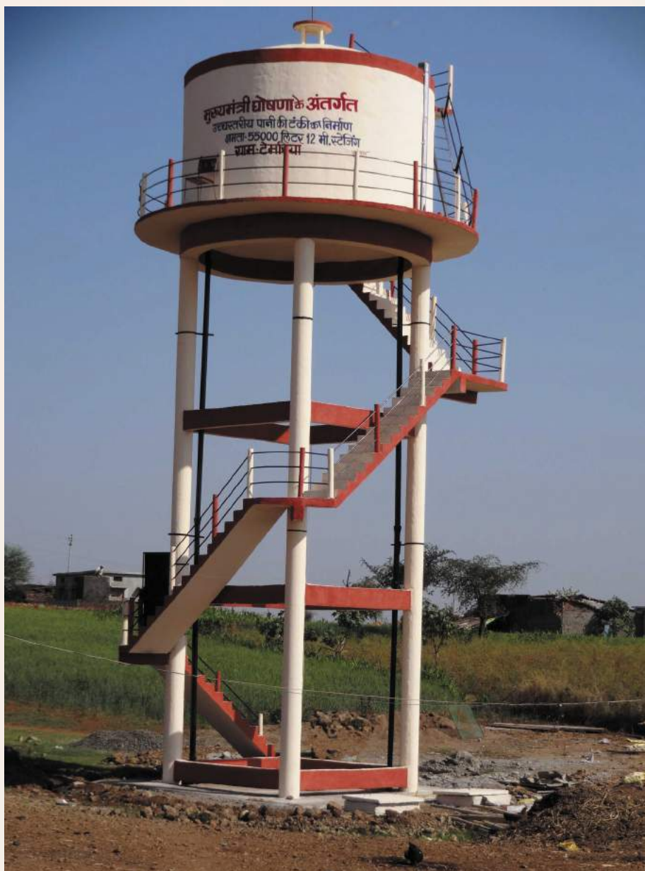
मुख्यमंत्रीजी द्वारा की गई घोषणाओं का समयबद्ध क्रियान्वयन :- उच्च स्तरीय पेयजल टंकी का निर्माण, ग्राम-टेमरिया
