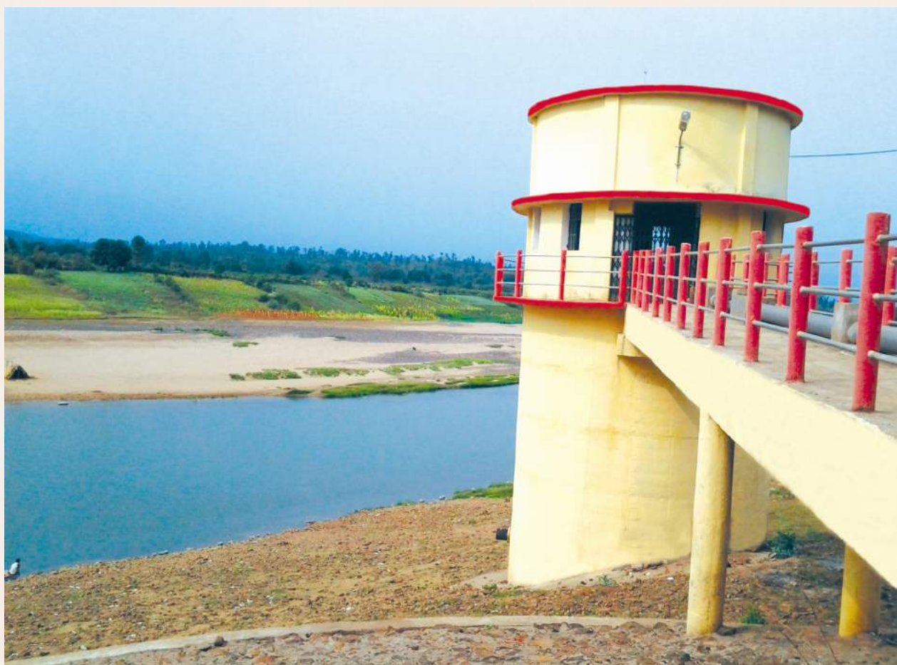
राष्ट्रीय ग्रामीण पेयजल कार्यक्रम के अन्तर्गत मण्डला जिले की समूह जलप्रदाय योजना के अन्तर्गत निर्मित इन्टेकवेल
