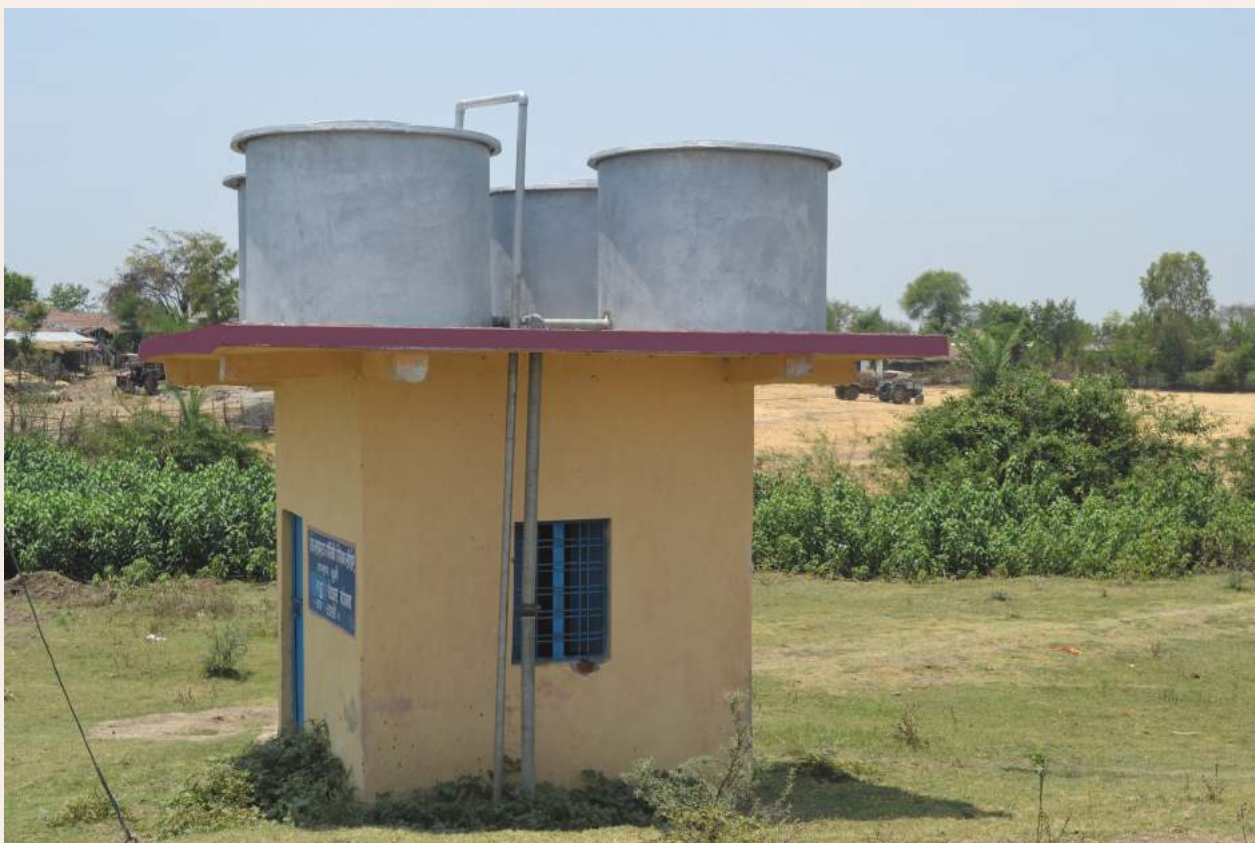
मुख्यमंत्री पेयजल योजना के अन्तर्गत ग्राम इटारसी, जिला सीहोर में निर्मित पम्प हाउस
