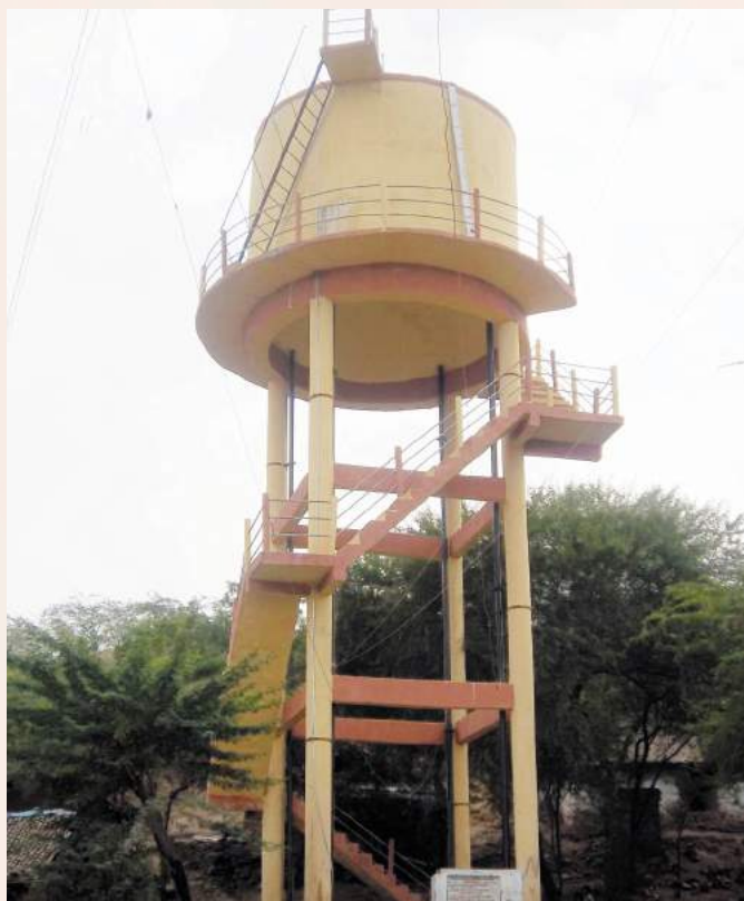
राष्ट्रीय ग्रामीण पेयजल प्रदाय कार्यक्रम के अन्तर्गत ग्राम बड़ागौव, जिला बड़वानी में उच्चस्तरीय पेयजल टंकी का निर्माण।
