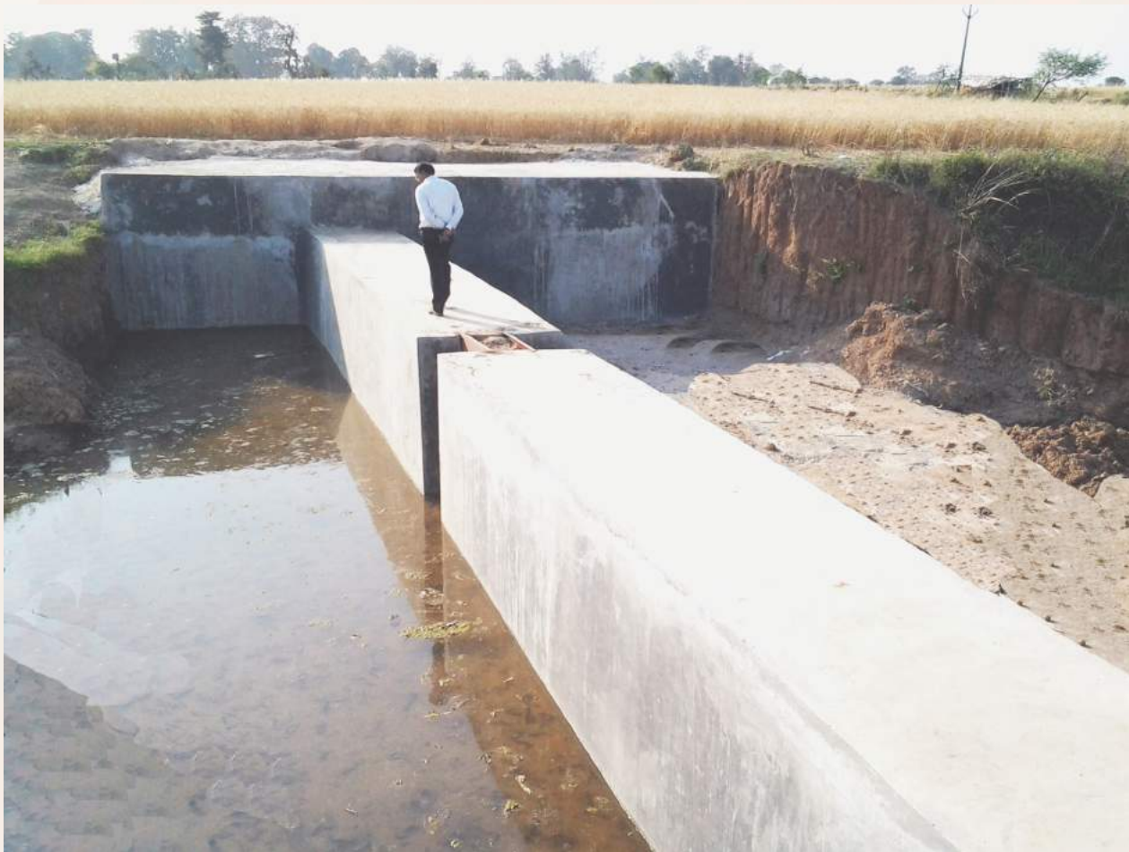
भूजल संरक्षण, संवर्धन व पुनर्भरण कार्यक्रम के अन्तर्गत स्टॉप डैम क्र. 2 का निर्माण, ग्राम पटेरा, विकासखण्ड पटेरा, जिला दमोह
