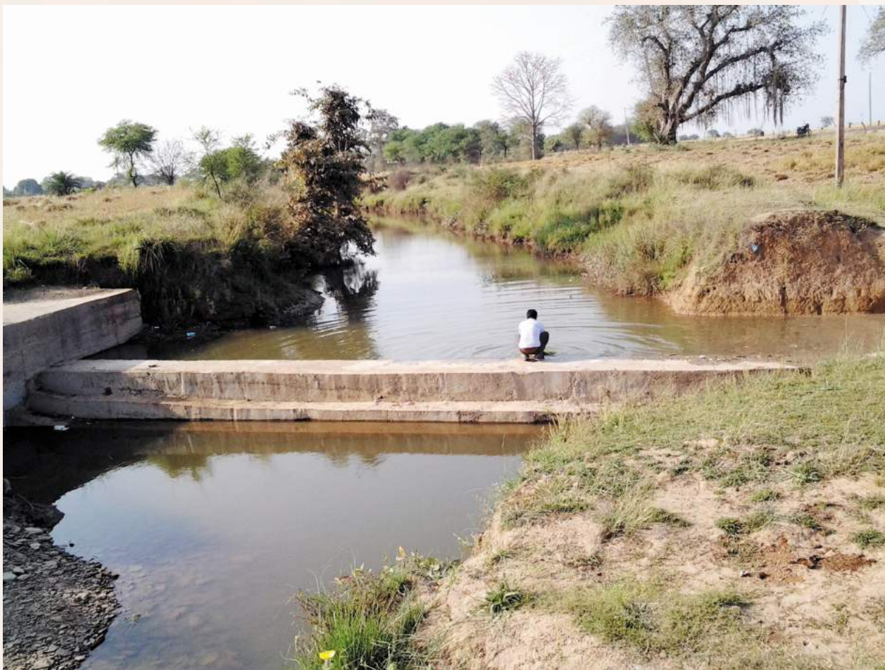
भूजल संरक्षण, संवर्धन व पुनर्भरण कार्यक्रम के अन्तर्गत स्टॉप डैम क्र. 1 का निर्माण, ग्राम पटेरा, विकासखण्ड पटेरा, जिला दमोह
