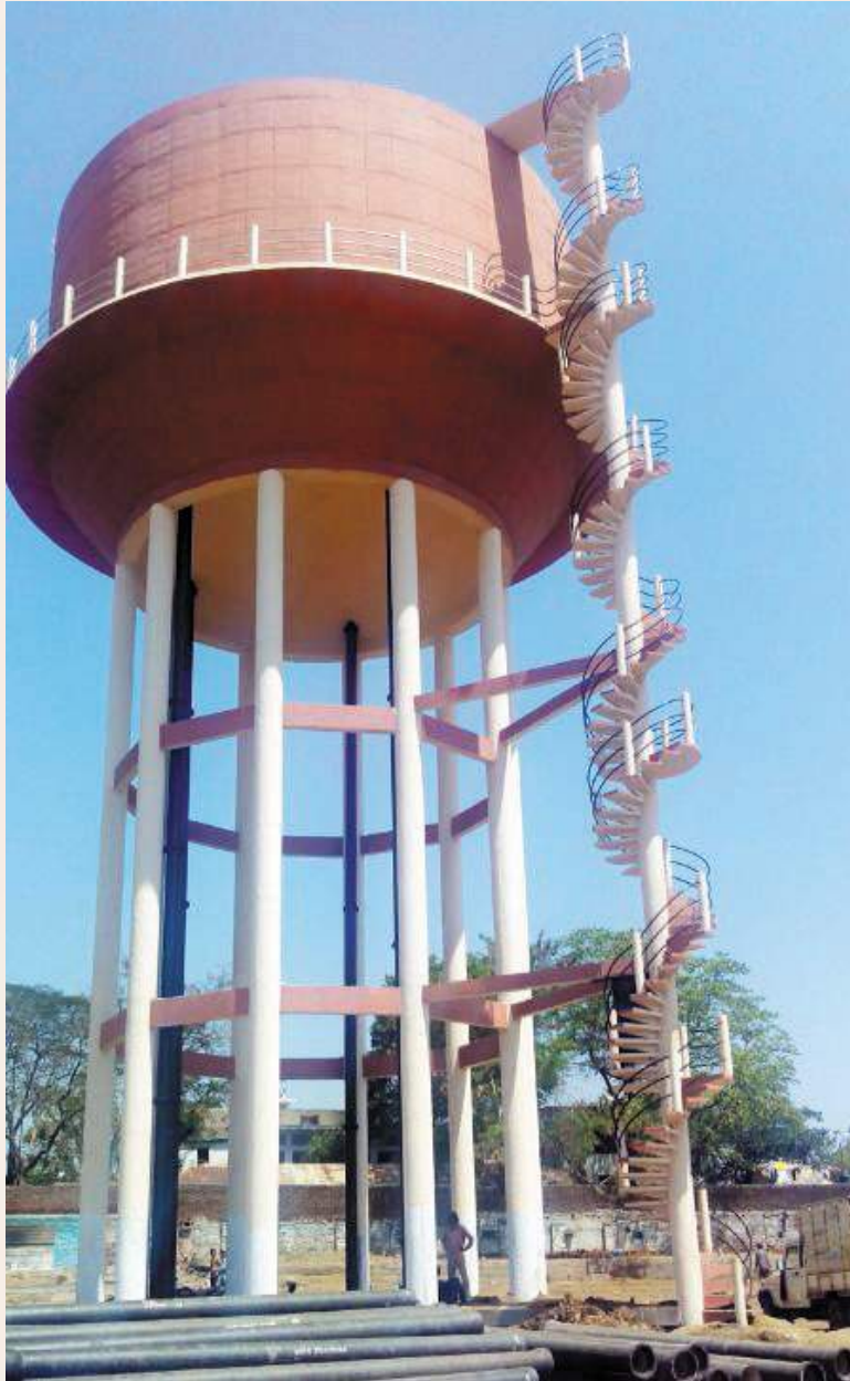
सागर जिले में बीना नदी पर आधारित, खुरई नगर की आवर्धन जल प्रदाय योजना के अंतर्गत उच्च स्तरीय टंकी का निर्माण, क्षमता 7 लाख लीटर
